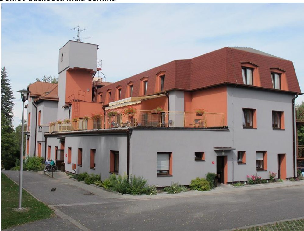
Obrázek 11: Domov důchodců Malá Čermná
