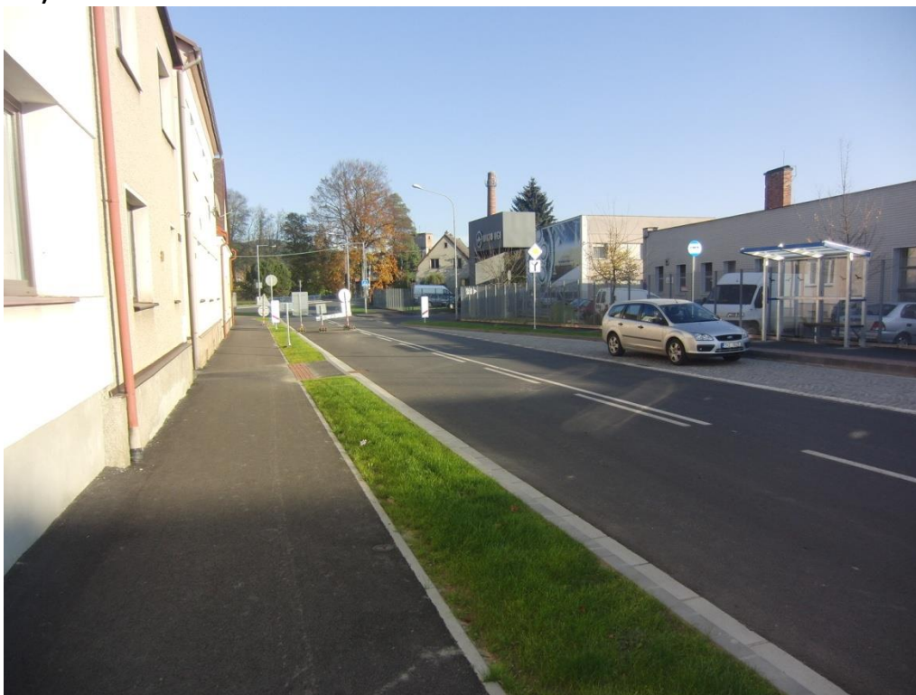
Obrázek 21: Část rekonstruovaného úseku v místní části Zbečník (v pozadí po pravé straně areál firmy Wikov MGI, a.s.)
